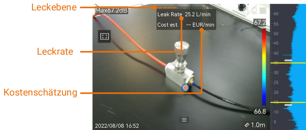
Abbildung 3-3 Schätzung einer Gasleckage
